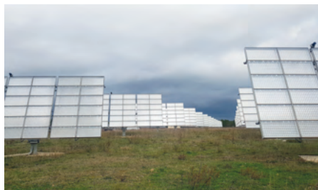
Photo 16 : Panneaux photovoltaïques trackers 2 axes à Grabels (34) (© Idele, parc géré par Neoen)
