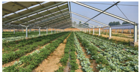
Photo 2 : Ombrières photovoltaïques mobiles installées au-dessus de cultures maraîchères (© Jeson/AdobeStock)
