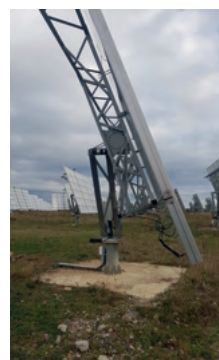
Photo 27 : Double-tracker mono-pieu sur dalle de béton (© Idele)
