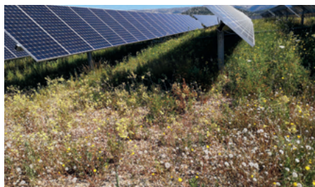
Photo 15 : Parc photovoltaïque à panneaux trackers 1 axe au Castellet (83) (© Voltaïa)
