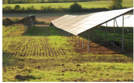
Photo 45 : Prairie semée dans un parc photovoltaïque (© Photosol)
