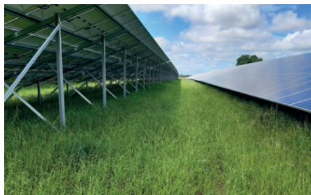
Photo 8 : L'hétérogénéité du rayonnement au sol est accentuée lorsque les panneaux sont bas (© Idelle)
