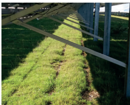
Photo 28 : Table fixe sur mono-pieu battu (© Idele)
