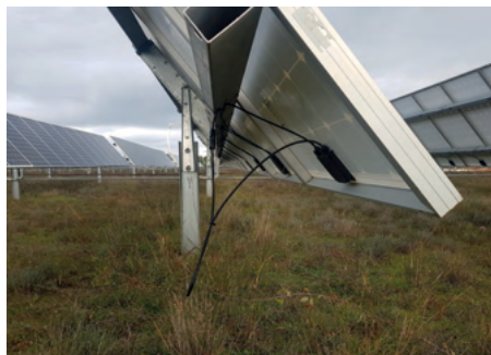
Photo 30 : Les câbles électriques ont tendance à pendre à faible hauteur, à l'arrière des panneaux, engendrant un risque d'étranglement, en particulier chez les jeunes animaux. (©Idele)
