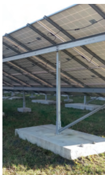
Photo 26 : Table fixe bi-pieux sur dalle de béton (© Idele)
