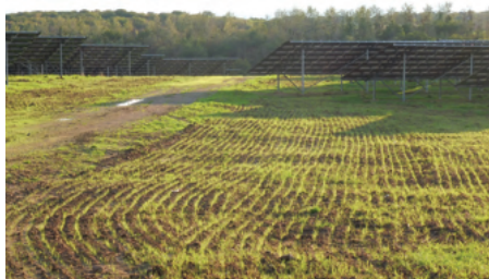
Photo 24 : Prairie semée dans un parc photovoltaïque (© Photosol)
