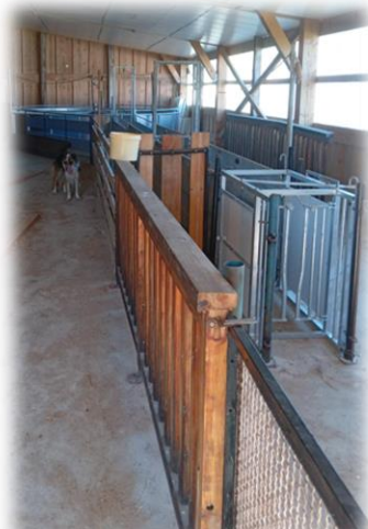
Parc de contention couvert Charpente/couverture/maçonnerie/camembert : 26 110 € HT en 2021
