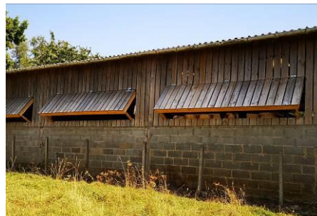
Trappes sur bardage bois
