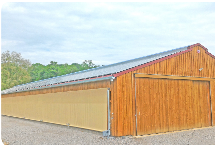
Une bergerie à énergie positive avec panneaux photovoltaïques
