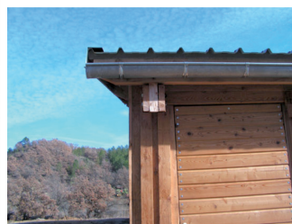
Détail d'angle et de gouttière
