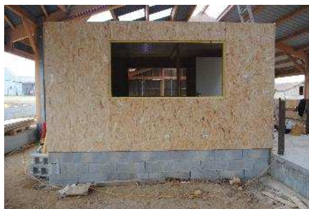
Le local technique est presque terminé
