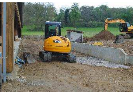
Les abords de la bergerie en cours de finition
