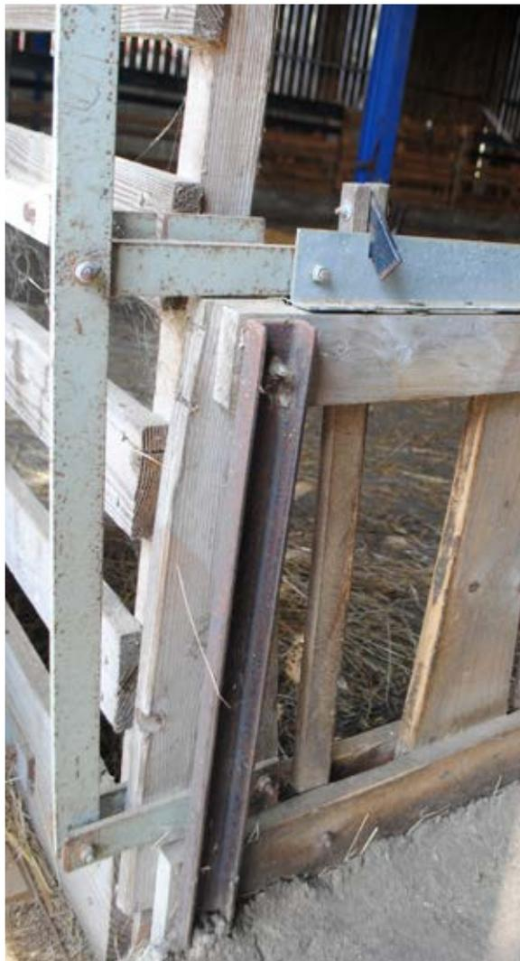
Du fer en U de 50 mm, boulonné en haut et en bas sur le cornadis, est bien adapté pour fabriquer les renforts. Cette solution convient bien pour les débuts et fins de longueur ainsi que pour les renforts intermédiaires qui sont positionnés tous les 1,5 m pour des éléments de cornadis de 3 m et tous les 2 m pour des éléments de 4 m. Cela évite, qu'avec le temps, les cornadis se mettent à gondoler et ne se ferment plus ou très difficilement.
