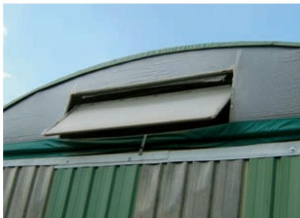
En pignon, des ouvrants pivotants en haut de porte permettent de régler l'entrée d'air dans le bâtiment.
